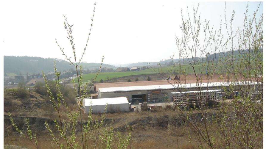
Blick von Norden auf das Betriebsareal
