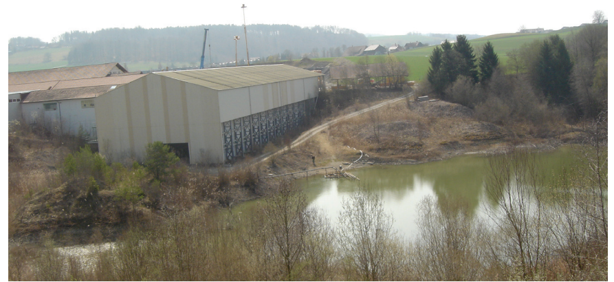
Blick von Nordwest auf das Betriebsareal
