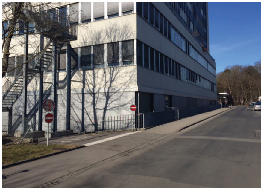
Abbildung: Zufahrtsbereich zur Einstellhalle im Untermattweg heute
