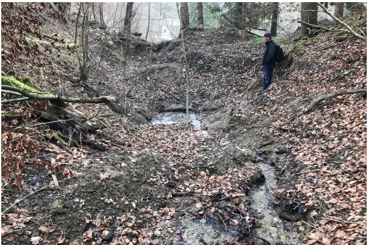
Bild 5: Einlaufbauwerk an Begehung vom 14.02.2022
