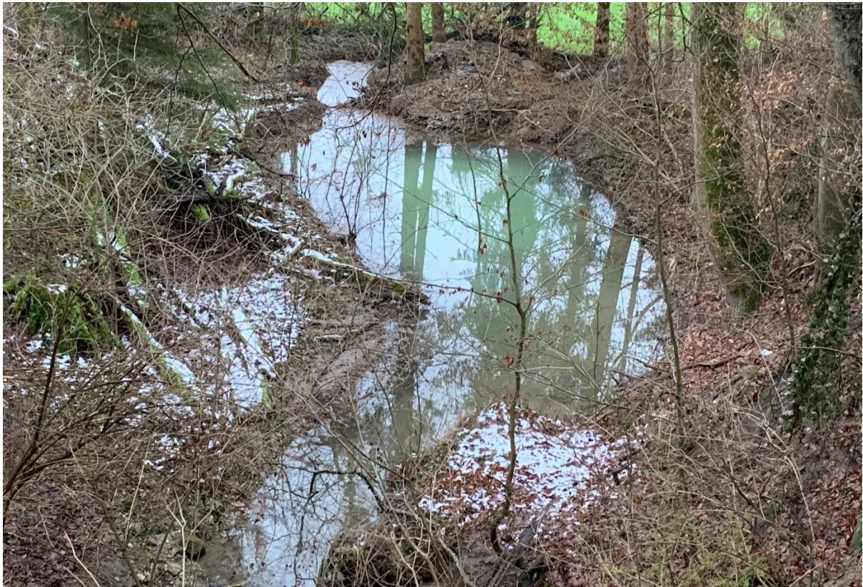
Bild 2: Eingestautes Einlaufbauwerk, Blickrichtung Gäbelbach
