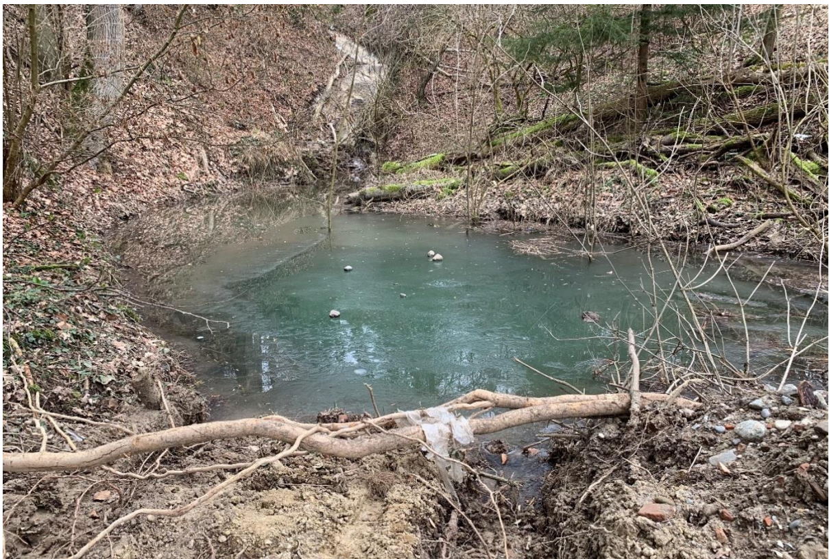
Bild 3: Eingestautes Einlaufbauwerk, Blickrichtung Obermatt
