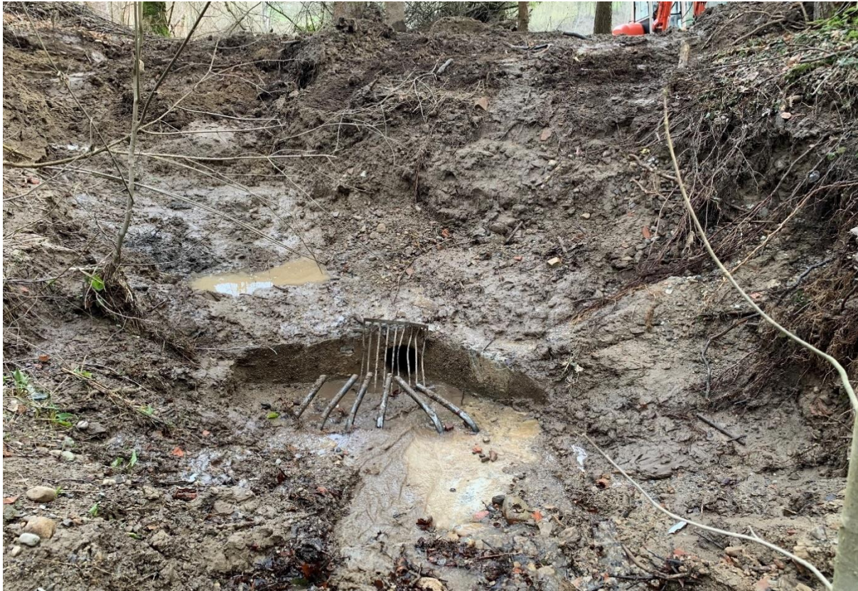
Bild 4: Einlaufbauwerk nach Freilegung
