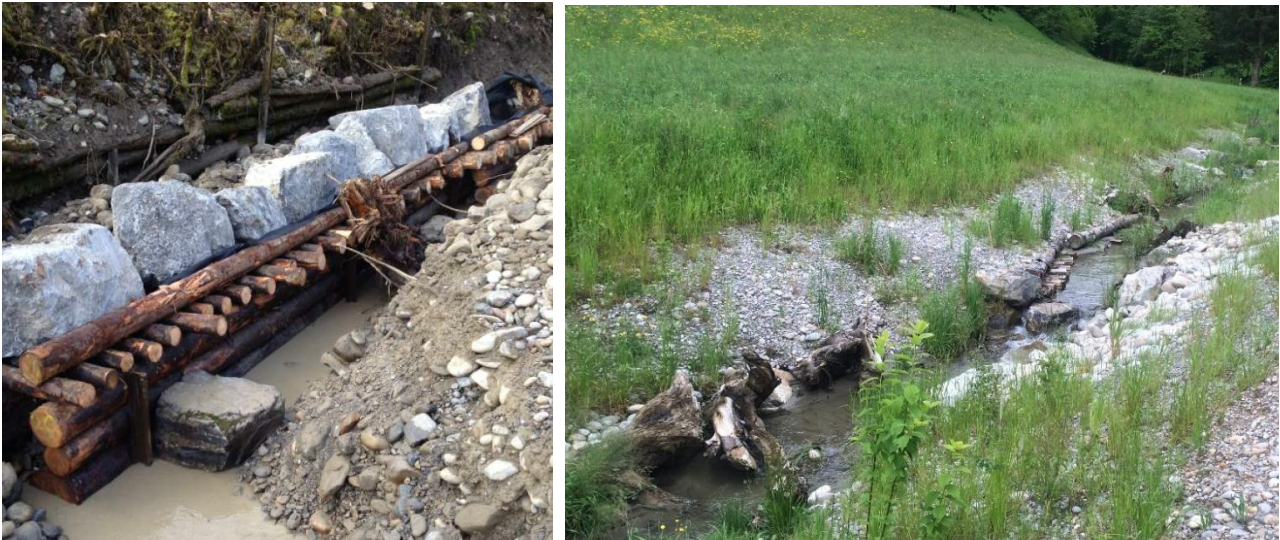
Abbildung 5.2 Böschungssicherung mittels Hozverbau / Gestaltung Wiesenbach
