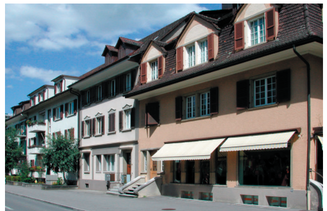
Geschlossene Bauweise, Bümplizstrasse:
