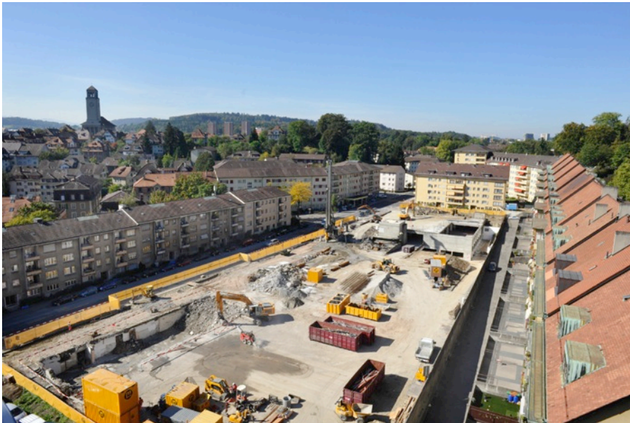
Brunnmatt-Ost, Mattenhof (Quelle: skyscrapercity.com | roeben.ch)
