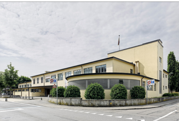
Die Schulanlage Stapfenacker (hier im Bild das Hauptgebäude an der Brünnenstrasse 40) wurde zu Beginn der 1930er-Jahre erbaut. Das Gebäude ist im kantonalen Bauinventar als schützenswert eingestuft.
