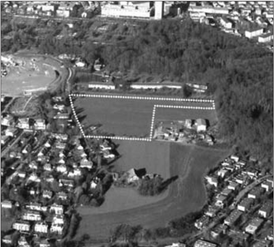
Flugaufnahme des Planungsgebiets Hintere Schosshalde zwischen Melchenbühlweg (links), Schosshaldenwald und der Rudolf Steiner-Schule. Unten rechts die Siedlung Obere Zollgasse/Robinsonweg.
