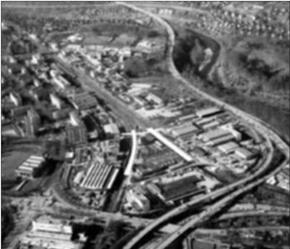
Das Planungsgebiet ESP Bern-Wankdorf mit dem Autobahnkreuz A 1 / SN 6 und mit den S-Bahn-Stationen an der Verzweigung der SBB-Linien Bern–Olten / Biel beziehungsweise Bern–Thun / Luzern sowie der Wankdorfkreuzung (unten links).
