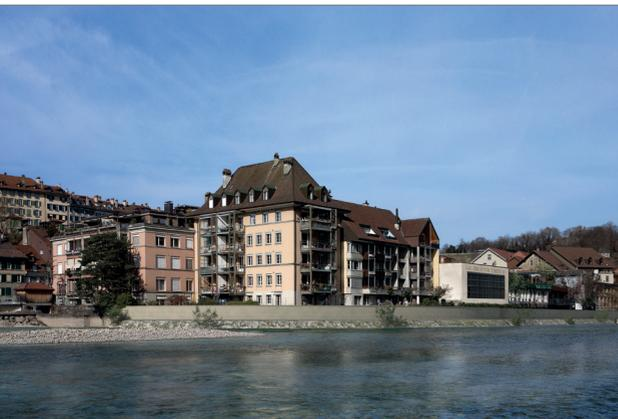
Visualisierung Mattequartier: Das besonders exponierte Quartier wird künftig unter anderem mittels einer neuen, ortsbildverträglichen Sandsteinmauer entlang der Aare besser geschützt. Zusätzlich wird eine unterirdische Dichtwand erstellt, die verhindert, dass Aarewasser über den durchlässigen Boden ins Quartier und in die Häuser gelangt.
