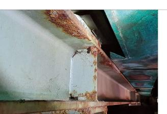
Die Kornhausbrücke wurde letztmals Ende des 20. Jahrhunderts saniert. Aktuelle Abklärungen haben ergeben, dass die Brücke in verschiedenen Bereichen Schäden aufweist. Auf dem Bild zu sehen sind Korrosionsschäden im Brückenunterhau
