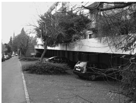
Unschöne und nach Bauordnung unzulässige Nutzung des Vorgartens
