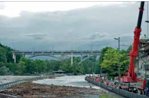
Auch kurz- oder mittelfristige Massnahmen tragen zur Bewältigung von Hochwassersituationen bei: Entfernung von Schwemmholz in der Mattenschwelle Anfang Juli 2012. Bild: Manu Friedrich, Bern.
