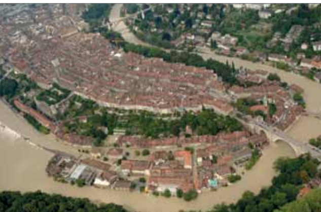
Land unter: Im August 2005 flutete das Hochwasser das Berner Mattequartier und hinterliess grosse Schäden. Solche Ereignisse sollen durch das Projekt «Gebietsschutz Quartiere an der Aare» nachhaltig verhindert werden. Bild: Markus Hubacher, Spiez.
