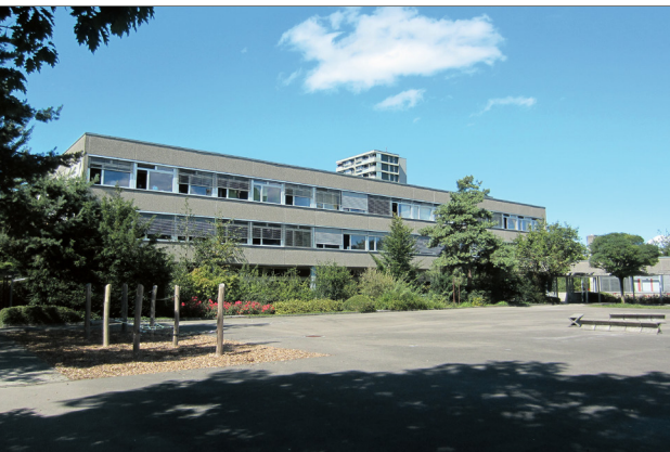
Der heutige Mittelstufentrakt ist eines von vier Gebäuden der Schulanlage Kleefeld in Bümpliz. Alle Gebäude befinden sich in einem schlechten baulichen Zustand.
