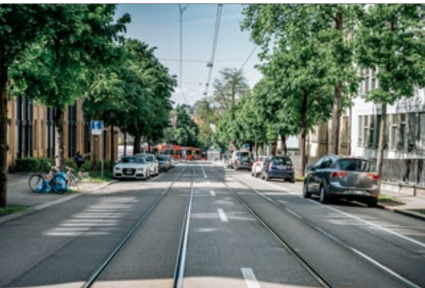
Der südliche Abschnitt der Monbijoustrasse muss umfassend saniert werden. Im Bild zu sehen ist die aktuelle Situation oberhalb der Tramhaltestelle Wander mit dem stark beanspruchten Strassenraum.
