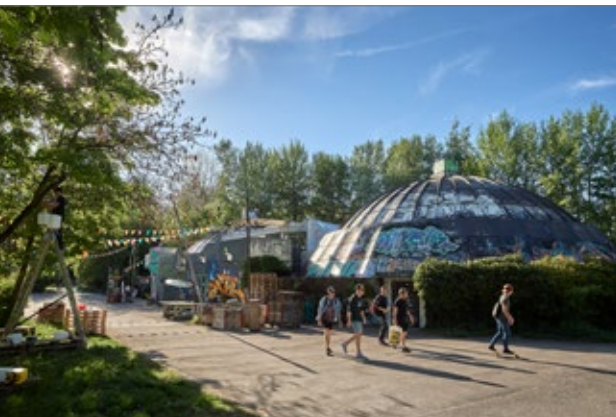
Das Jugend- und Kulturzentrum Gaskessel kann an seinem bisherigen Standort bleiben. Bauliche und betriebliche Massnahmen sollen das Nebeneinander der verschiedenen Nutzungen auf dem Areal gewährleisten. (Bild: ewb)
