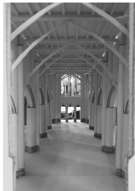
▲ Im Schnitt-Modell des Berner Münsters ist die auf Stützbögen gelagerte Balkendecke über dem Kirchenraum gut zu erkennen. Auf der Holzdecke werden die RestauratorInnen auf Rollgerüsten arbeiten, so wie sie das bereits bei der Restaurierung des Chorgewölbes getan hatten. Foto: sw
