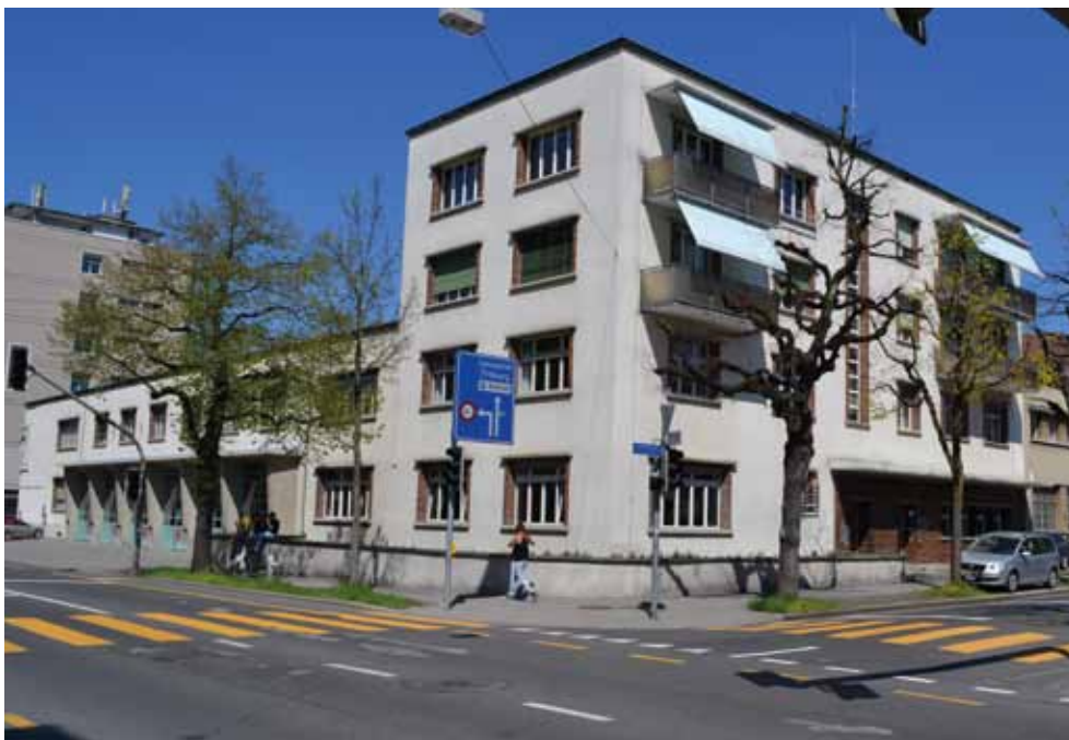
Der schützenswerte Kernbau der Feuerwehrkaserne an der Viktoriastrasse
