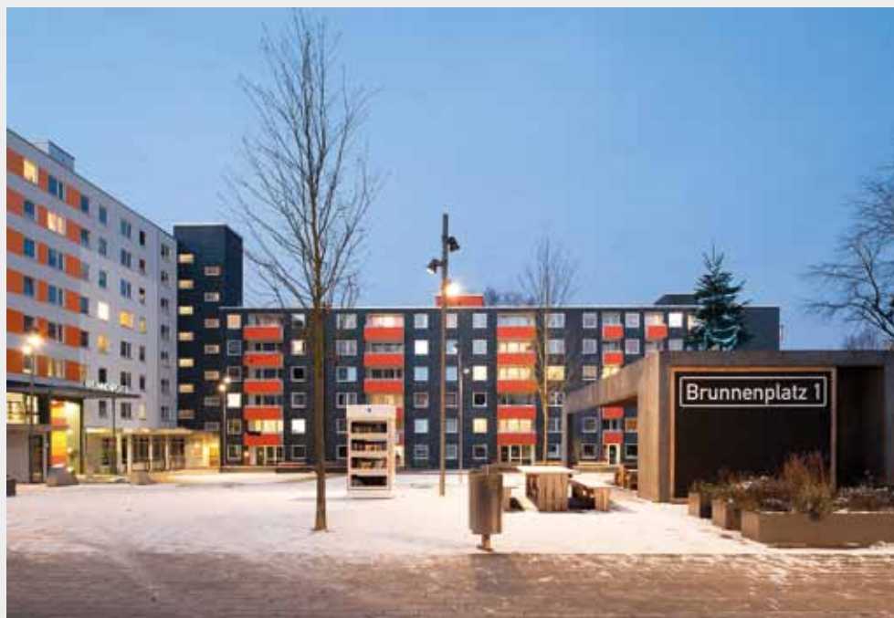
Der neu gestaltete Brunnenplatz in der Inneren Hustadt in Bochum (Foto: VBW Bauen und Wohnen GmbH - Höhn)
