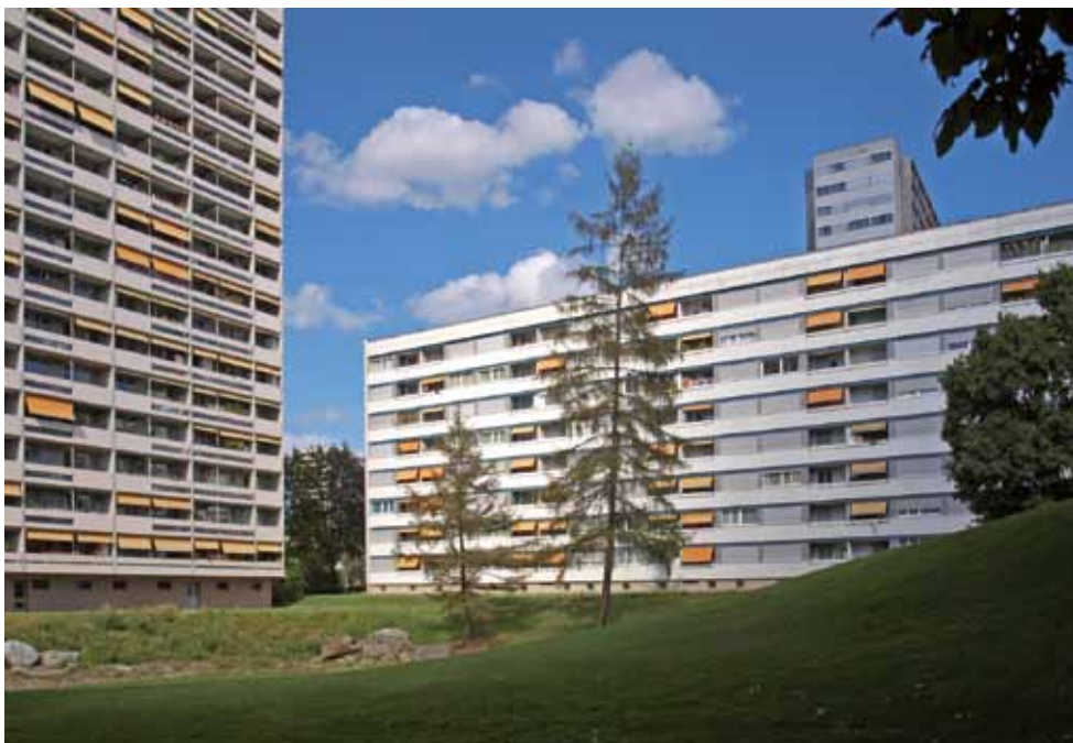
Die Sanierung des Tscharnerguts (Waldmannstrasse 25) ist eines der Pilotprojekte beim neuen Standard Nachhaltiges Bauen Schweiz (Bild: Peter Sägesser)
