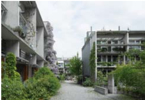
Innenhöfe und Gassen in der Siedlung Baumgarten (Foto: Dominique Uldry)
