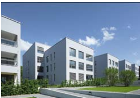
Brünnen, Baufeld 6: Wohnzeile und Einzelbauten (Büro B Architekten und Planer, Foto: Dominique Uldry)
