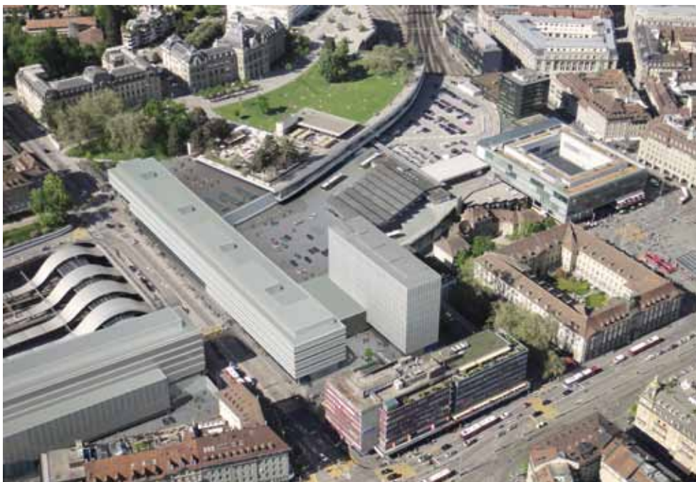
Die drei Gebäude des künftigen PostParc aus der Luft betrachtet.
