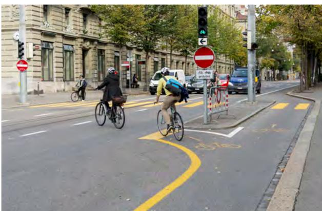
Bei Fussgängerübergängen ist der Einbau einer Schutzinsel zu prüfen. Dies stellt sowohl für Zufussgehende wie auch für den Veloverkehr (bei LSA unabhängige Durchfahrt) eine gute Lösung dar.
