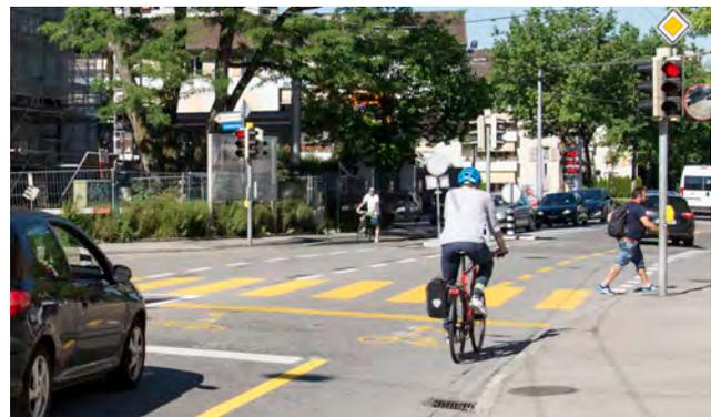
Knoten Standstrasse/Scheibenstrasse: Der aufgeweitete Radstreifen („Velosack“) ermöglicht während den Rotphasen ein Einfädeln zum Linksabbiegen. Bei Grünstart befindet sich das Velo in Sichtkontakt vor dem motorisierten Verkehr.
