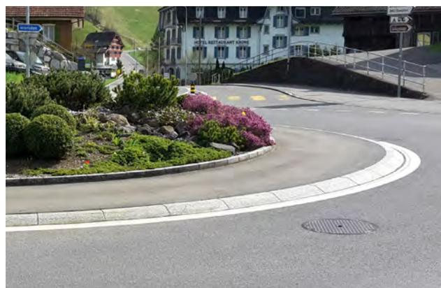
Der aufgeschiftete Innenring ist ein wichtiges Ausführungsdetail. Damit werden ein genügender Ablenkwinkel und in Folge dessen tiefe Geschwindigkeiten des motorisierten Verkehrs sichergestellt. (Bild: Jonas Zurschmiede).
