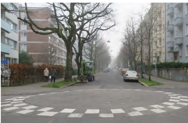
Wo zu hohe Geschwindigkeiten des MIV vorherrschen, müssen unterstützend Vertikalversätze eingesetzt werden. Die kreisrunde Aufschriftung füllt den ganzen Knotenbereich aus, da sie ansonsten als Kreisverkehr missverstanden werden kann.
