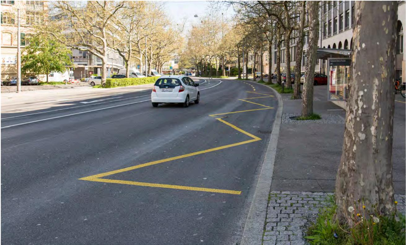
**Variante A:** Die Variante A zeigt den Standardfall. Der Radstreifen endet vor der Haltestelle und wird danach wieder fortgesetzt. Der Unterbruch wird möglichst kurz gehalten, ohne haltenden Bus besteht eine durchgängige Veloführung.
