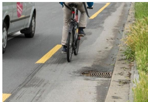
Problematisch: Der Einlauf nimmt vom schmalen Radstreifen eine erhebliche Breite weg; der Deckbelag ist zudem beschädigt. Dies führt zu Ausweichverhalten und zu Sturzgefahr.
