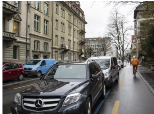
Nachher-Zustand: Die Fahrbahn ist unverändert, anstelle der Schrägparkierung gibt es einen Gehweg, einen Radstreifen in Gegenrichtung und Parkfelder in Längsrichtung.
