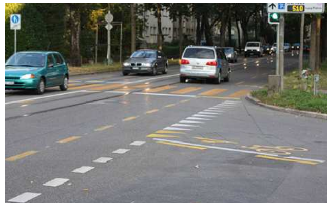
Bei starker Verkehrsbelastung durch den MIV oder bei Tramgleisen kann das indirekte Linksabbiegen als Zusatzangebot oder Hauptangebot geprüft werden. Die Anlage auf der Muristrasse (Bild) weist eine bedarfsgesteuerte Lichtsignalanlage auf.
