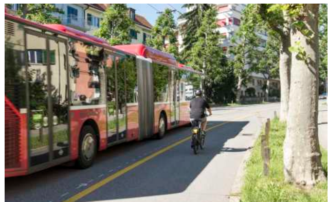
Aufgrund Steigung: Markierung eines Radstreifen anstelle Umweltspur, damit kann ein gefahrloses Überholen gewährleistet werden.
