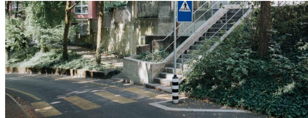
Sofortmassnahmen Markierung und Signalisation
