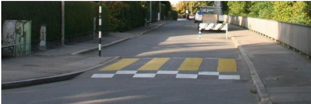
Kombination vertikalem Versatz und Fussgängerstreifen
