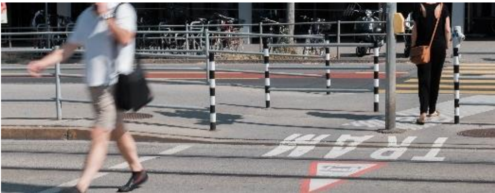
Um Personen bei der Tramhaltestelle Kocherpark zu schützen, wurden Umlaufsperrn errichtet.
