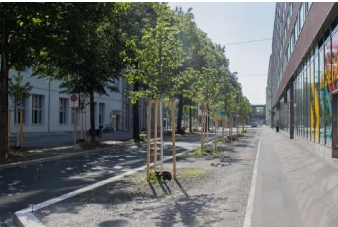
Zürich / Optingenstrasse: Rückbau von Fahrbahnen zur Hitzeminderung
