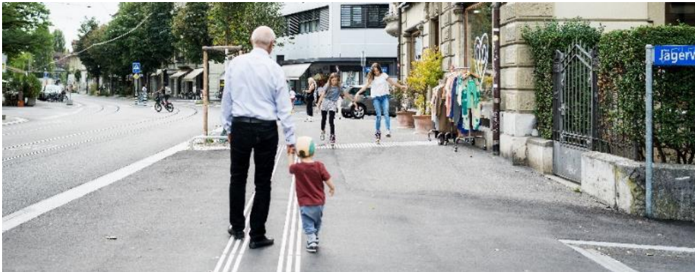
Durchgehendes Trottoir am Knoten Moserstrasse/Jägerweg mit Leitlinien.
