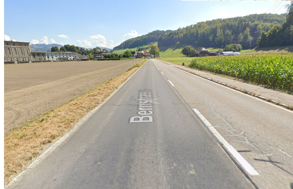
Sanierung Bernstrasse Deisswil (Baustart 2024)
