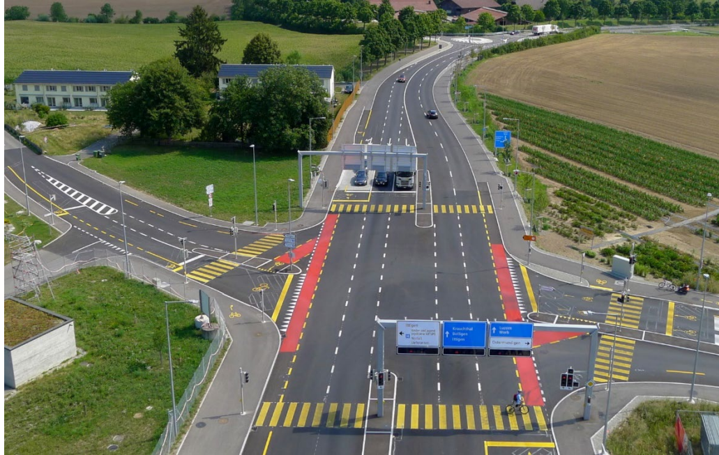
Korrektion Bolligenstrasse Nord (realisiert)
