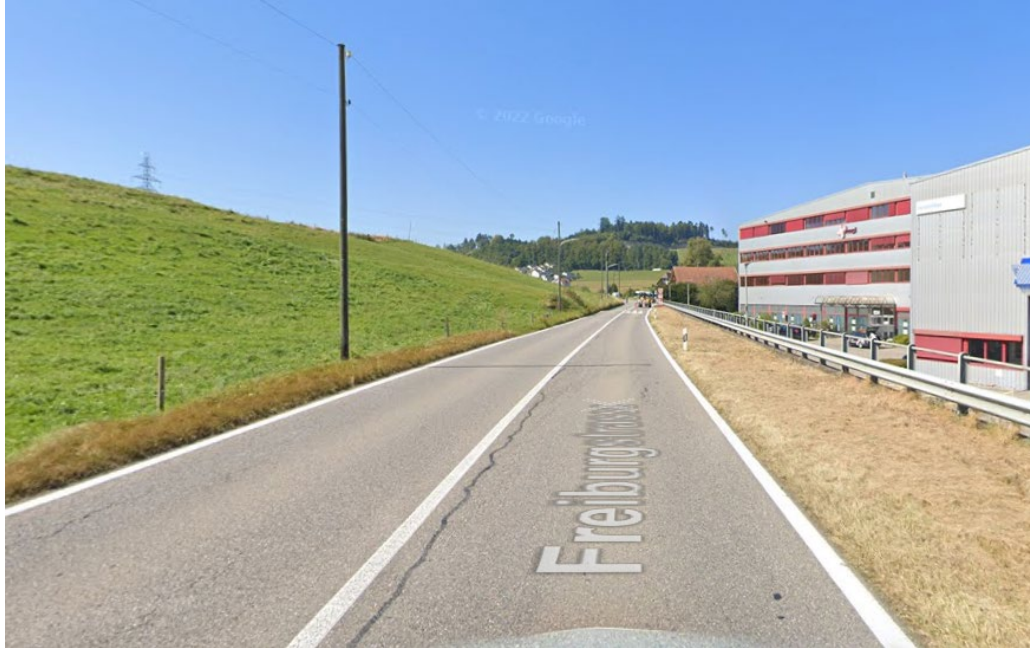
Sanierung Freiburgstrasse Oberwangen (Auflage Anfang 2023)
