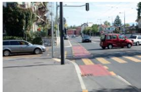
Wechsel vom Radweg zum Radstreifen im Knotenbereich: Ermöglicht direktes Linksabbiegen und verdeutlicht die Vorrangsregelung (Genf).
